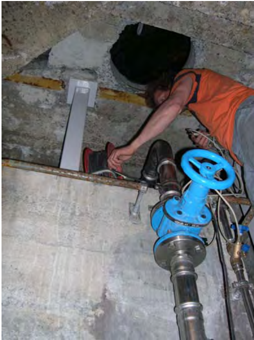
Abb. 24: Bild aus dem Denkmalinneren: grosse Kernbohrung für den Einstieg ins Innere der Bronzeplastik; Stützkonstruktion des rostigen Eisentägers und Zufluss der Brunnenanlage. (2004)
