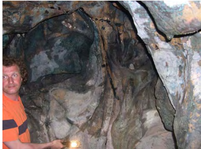
Abb. 25: Bild aus dem Inneren der Bronzeplastik: Blankstrahlungen und Verschweissungen (goldbraun); Silikonabdichtungen (schwarz); Luftfeuchtigkeit im Innern: im Sommer bis 100% Kondensation des Wassers an den Innseiten
