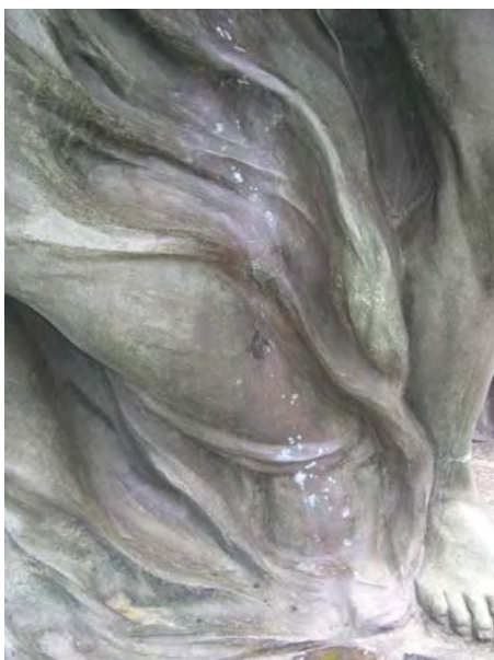
Abb. 23: Punktuelle Neubildung von Brochantit bereits zwei Jahre nach der Restaurierung. Die hohe Luftfeuchtigkeit im Inneren der Bronzeplastik kondensiert und reagiert vermutlich mit Schwefeldioxid und Sauerstoff zu Schwefelsäure, die durch die Porosität bis an die äussere Oberfläche gelangt. (Mai 2004)
